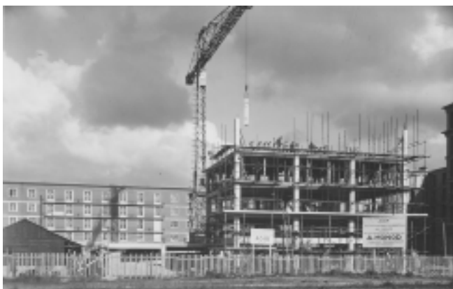
Figure 2 : Erection of the prefabricated framework in situ, Porte Océane Nord. (Photo F. Fernez, Fonds André Hermant, Archives municipales du Havre).
