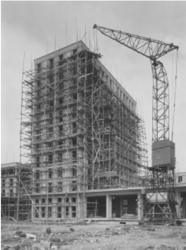
Figure 1: Traditional construction of one of the ISAI towers, Place de l'Hôtel-de-Ville. (Fonds André Le Donné, Archives municipales du Havre).
